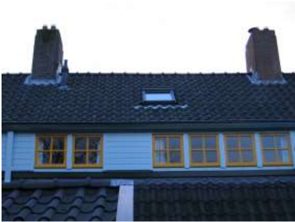
Dakraam achterzijde eenlaagse bebouwing Trendsetter Beijerinckstraat 4
