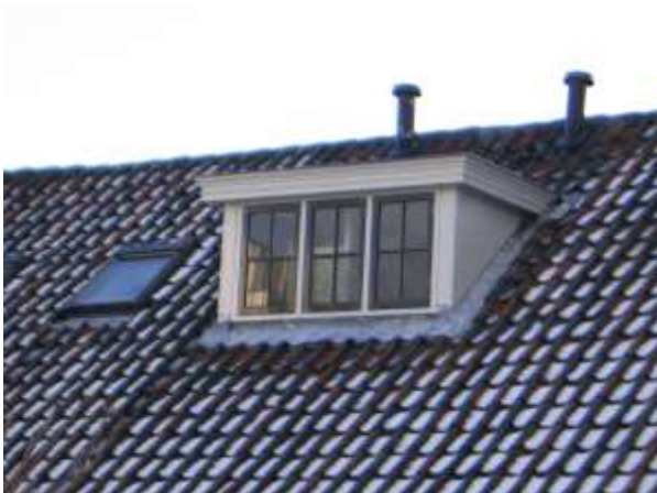
Dakkapel achterzijde Trendsetter Frederik Matthesstraat 13-15
