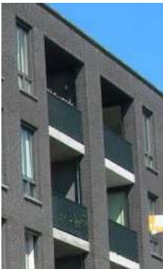
Balkon binnen gevel
