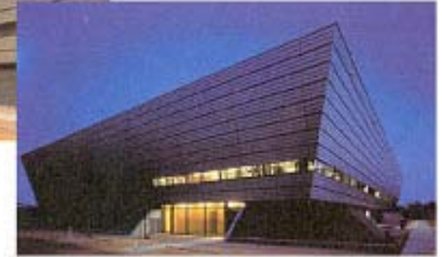
Afbeelding 24: Gesloten gevel met voorkant uitstraling
