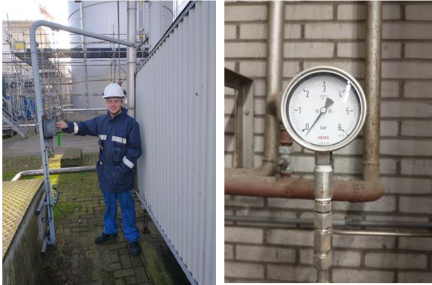
Figuur 2 Op 28 januari 2022 is de laatste pomp (nr 124) op het DSM-terrein stilgezet. Vanaf dat moment is enkel het puttenveld aan de Meeslaan en de Prinses Beatrixlaan nog in gebruik.
