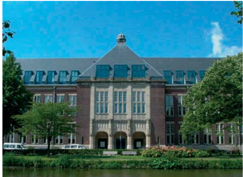
TU-gebouw verbouwd tot woningen
