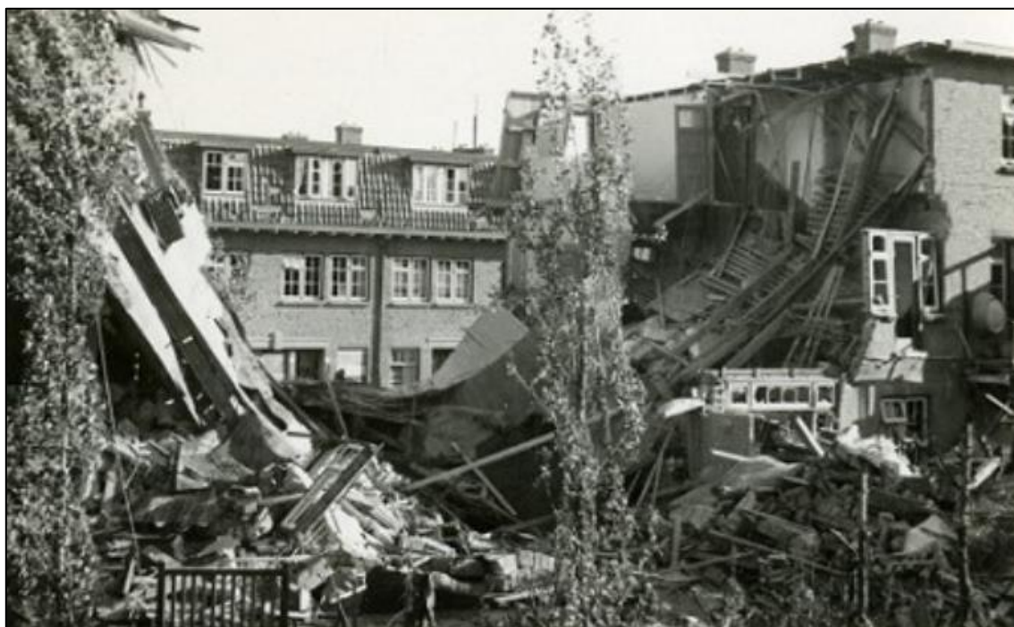
Afbeelding 4: Kloosterkade, schade na het bombardement in de Wippolder. 104
