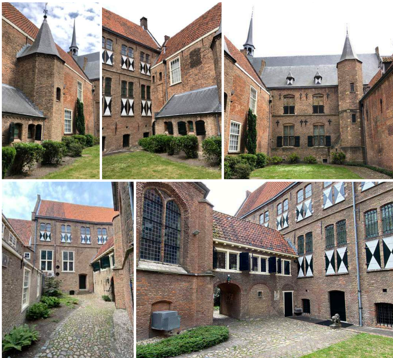
Restauratie door architect Lansdorp in de periode 1936 - 1962: rechtsboven de 20 ste eeuwse gevel met traptoren van de Spinkamers aan de Binnentuin. Onder de 20 ste eeuwse verbindingsgang tussen de Kapittelzaal en de Historische Zaal.
