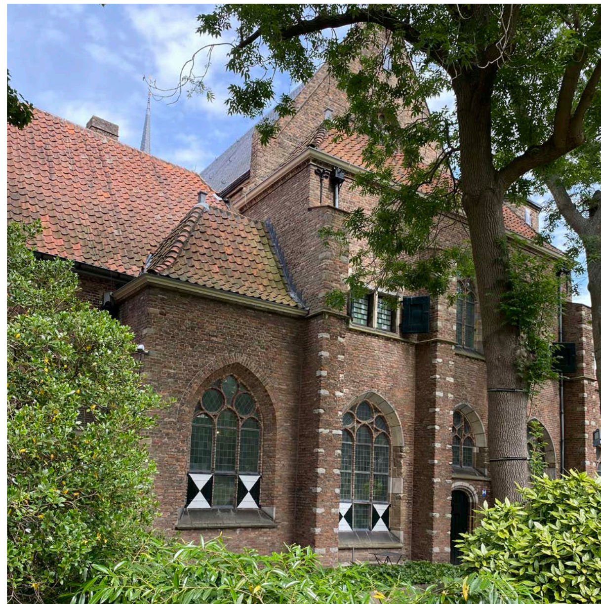
Restauratie van de gevel van de Narthex met links het nieuw toegevoegde travee.
