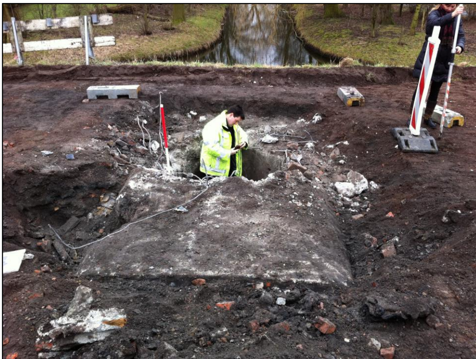
Afbeelding 7: Op 28 februari 2012 werden tijdens wegwerkzaamheden aan de Brasserskade de resten van een bunker aangetroffen. Voor zover bekend werden geen CE aangetroffen. 565
